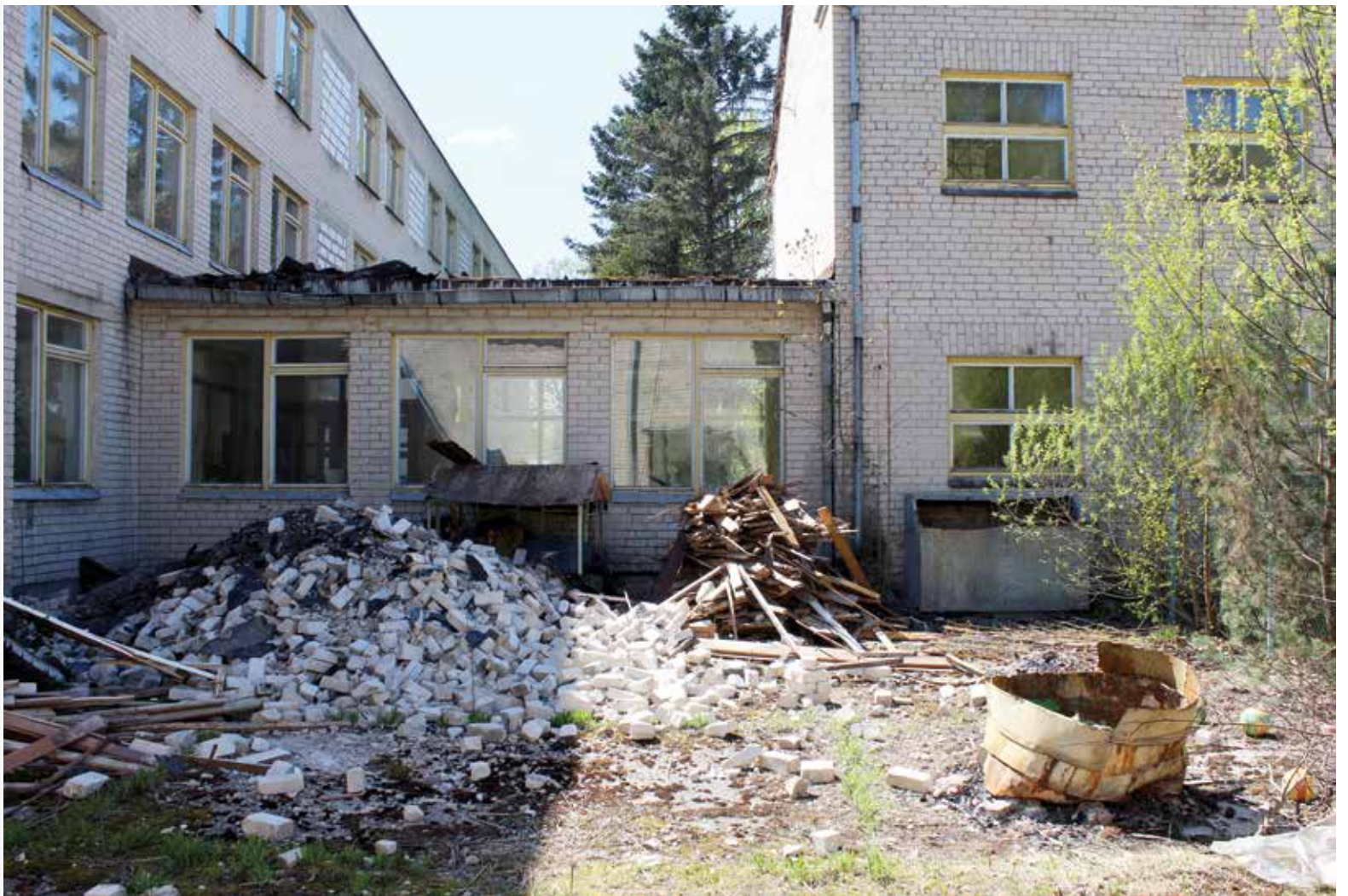
Iš lauko pusės pastatą planuojama apšiltinti
